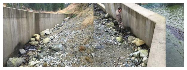
Abb. 3\* und 4\*: Von Regenfällen unterspülter Hang. Die dadurch entstandene Hangrutschung verlegte den Fischaufstieg! Leider versteckt sich der Fischaufstieg hinter der großen betonierten Wehrwange und ist wohl auch für den Kraftwerksbetreiber schwer einsehbar – weil ansonsten der Fischaufstieg unverzüglich wieder hergestellt worden wäre!!
